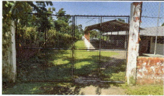
FOTO 7: Mantenimiento a portones de metal PATIO I
