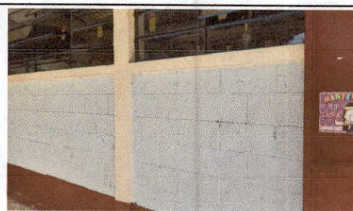
FOTO 6: Pintura en muros exteriores e interiores
