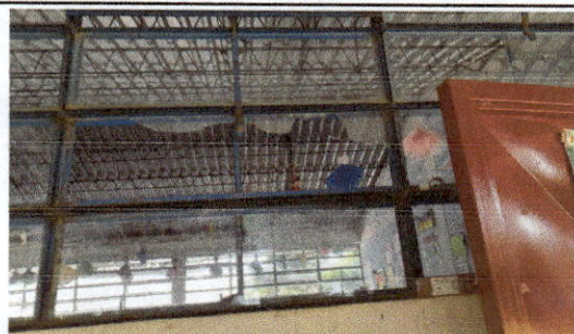
FOTO 5: Sustitución de vidrios
