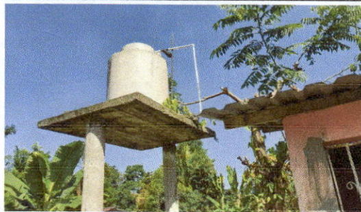
FOTO 3: Sustitución de depósito de agua 1100 lt
