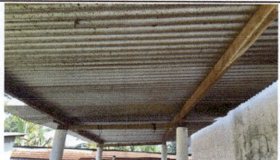
FOTO 10: Sustitución de lámina, por lámina troquelada aluzinc calibre 26 PATIO II
