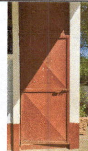
FOTO 4: Mantenimiento a estructura (lijado, cambio de tubo , cepillado, sujetiones, aplicación de pintura) EN AULA
