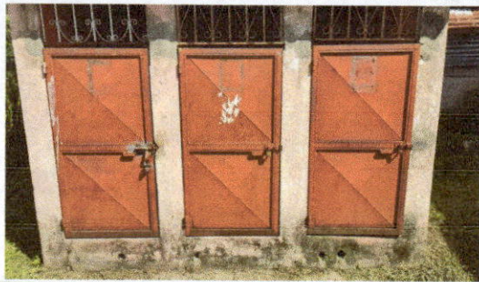
FOTO 1: Mantenimiento a estructura (lijado, cambio de tubo , cepillado, sujetiones, aplicación de pintura)
