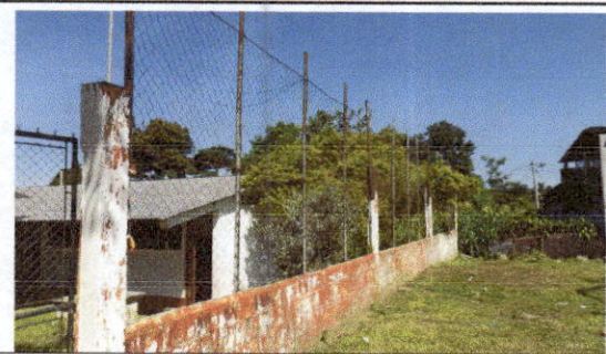
FOTO 8: Reparación de tubo hg y malla galvanizada PATIO I
