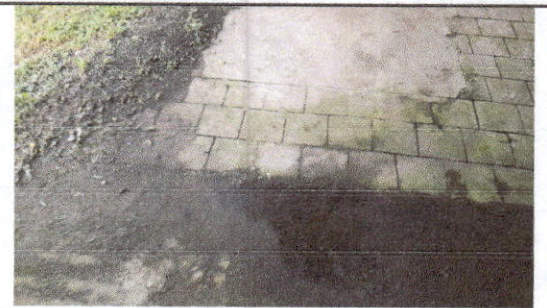
FOTO 12: Reparación de planchas de concreto de patio II
