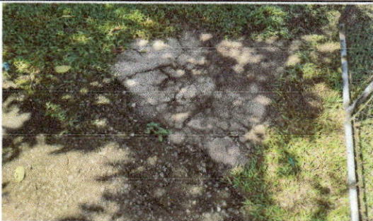
FOTO 9: Reparación de planchas de concreto de patio PATIO I
